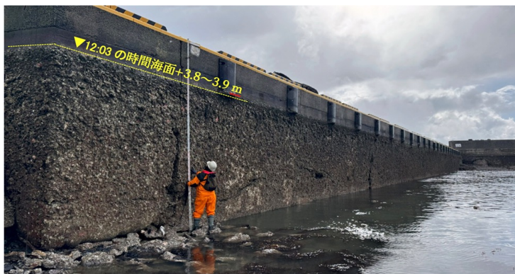
写真1 鹿磯漁港の防潮堤に固着した生物遺骸が示す隆起の様子。人が持っている標尺の長さは5m。
