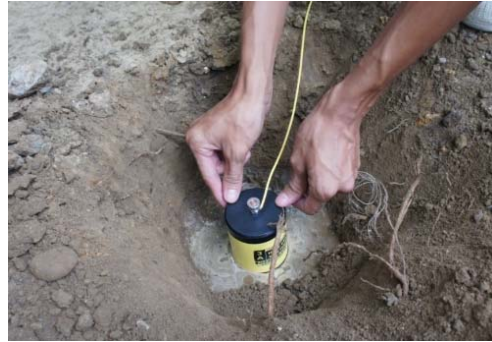
將電極放入洞中並倒入泥漿狀電解液
