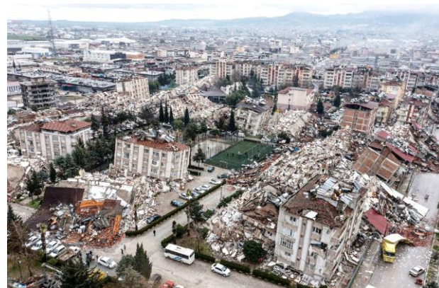
▲土耳其南部哈塔伊(Hatay)震後大量建物嚴重受損
