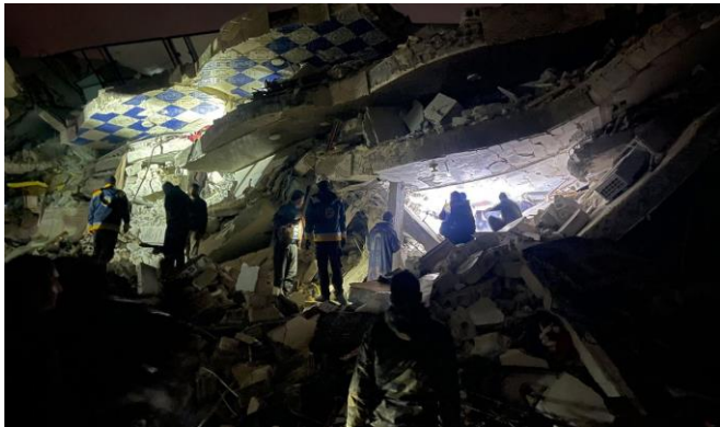
▲敘利亞搜救隊六日凌晨在土敘邊界伊德利卜省 (Idlib province) 坍塌建物裡找尋生還者
