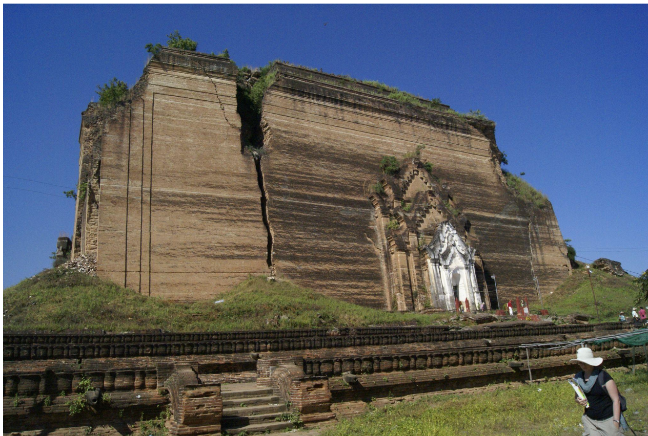
位於實皆東北方的敏貢大佛塔。這座未完成的佛塔在1839年時受到地震強地動影響而嚴重損壞 (照片由台大王昱老師提供)
