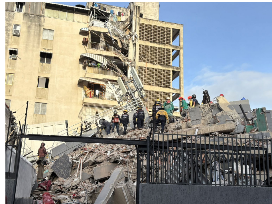
卡拉卡斯內的建物倒塌 ( 影像來源: @johanzapata )
