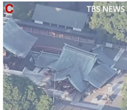
八代宮神社的建築倒塌
