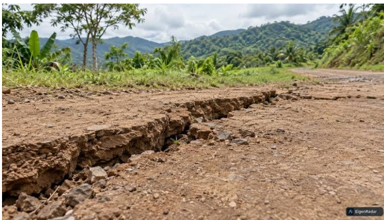
可能與斷層地表破裂有關的山區道路裂隙痕跡。(圖片來源: EigenRadar / 地質科學簡報, https://eigenradar.com/en/science/briefs/2026-10-10/panama-shallow-strike-slip-earthquake/ )
